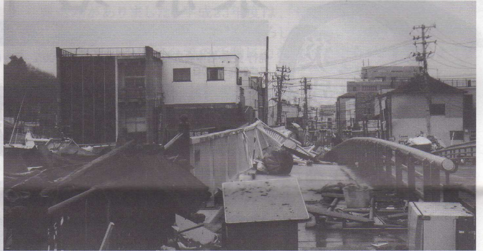
中瀬付近 内海橋の欄干が曲がっているのがわかる
