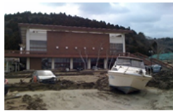
被災した石巻市民会館
