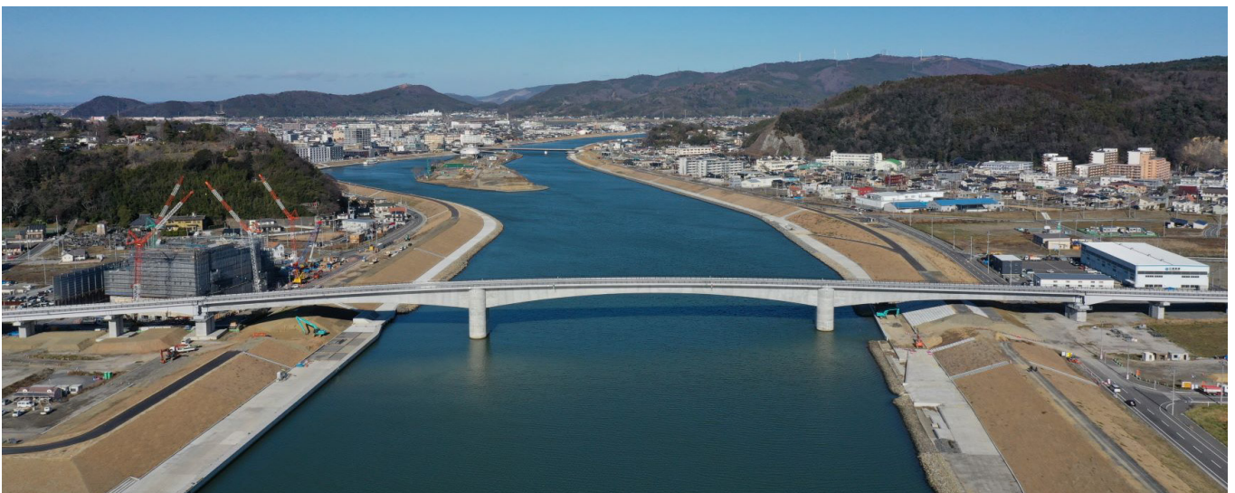
▲石巻かわみなど大橋(令和3年12月撮影)
